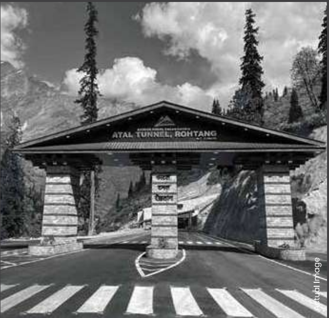
ATAL TUNNEL, ROHTANG
